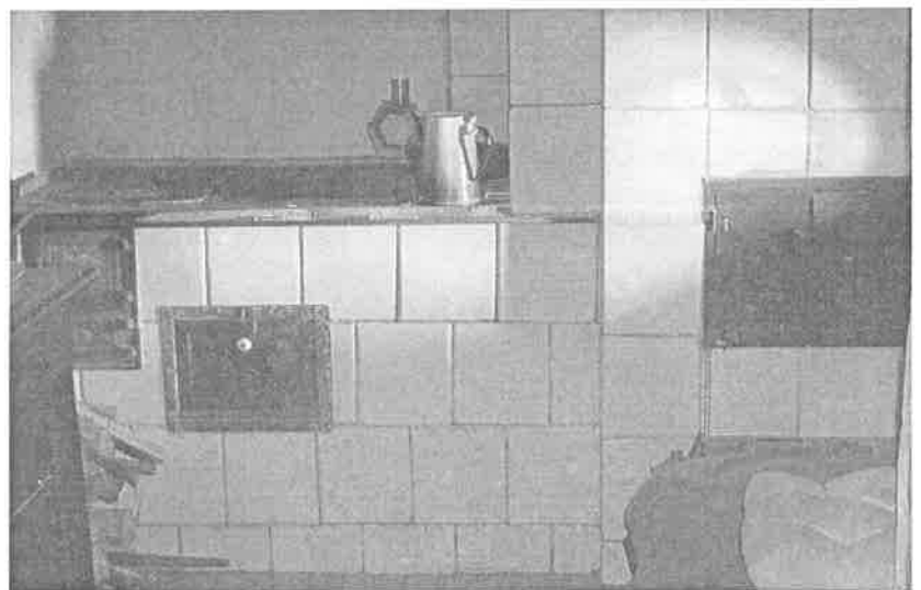
Ebenso beeindruckend ist auch die Küche (mit offenen Kamin), die sicherlich aus dem 19. Jahrhundert stammt, original eingebaut, mit Kochstelle, Backofen und Wärmeröhre
