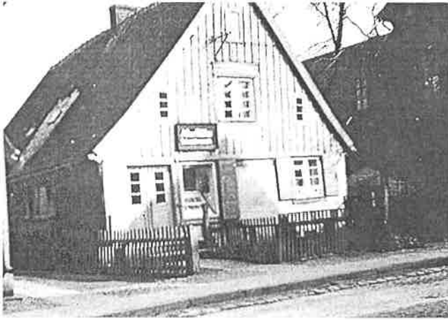
Ehemaliges Wohnhaus von Schneidermeister Carl Ebberle in der Schlosserstraße
