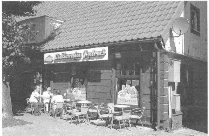
Die ehemalige Schlachtereie Albrecht. Hier ist heute ein sehr schönes modernes Cafe eingerichtet. Dach und Fassade alles erneuert.
