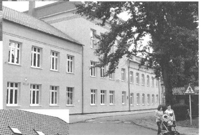
Die ehemalige Volksschule. Hier ist alles renoviert worden Dach, Fassade und Fenster.
